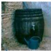
Citerne de récupération des eaux pluviales
