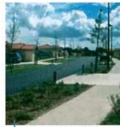
Noues engazonnées en zone pavillonnaire, Villefontaine
