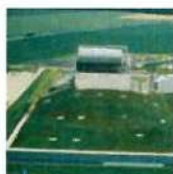
Toiture végétalisée de l'usine Monthyon
