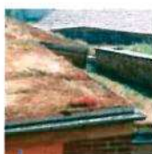
Toitures végétalisées, lycée Jacquard, Caudry
