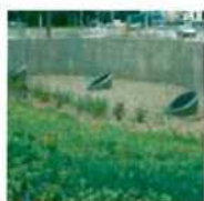
Puits d'infiltration aval associé à un bassin de rétention, Beynost
